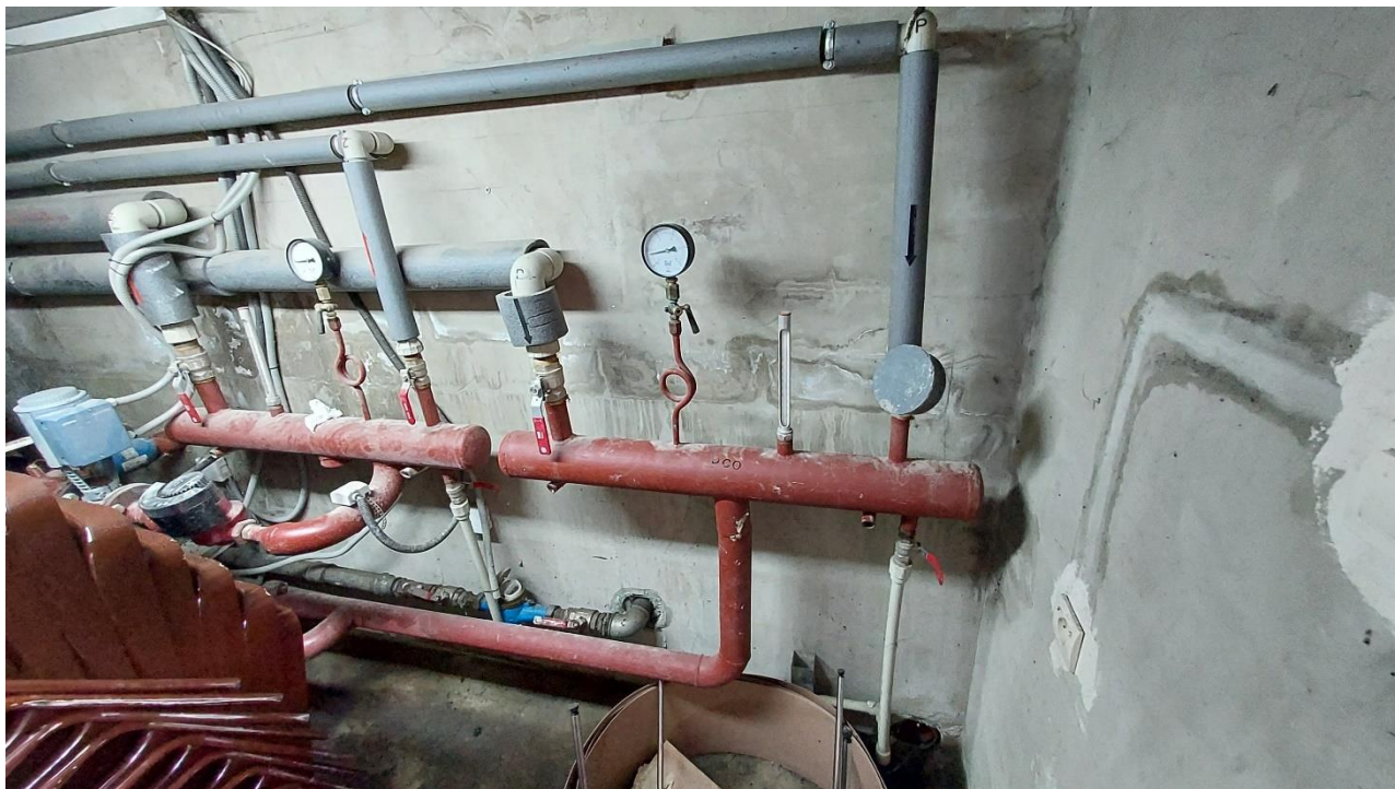
Zdj. Podrozdzielnia ciepła
